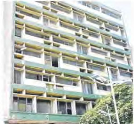
Este edificio de 9 pisos, que está en restauración, será una nueva sede de la Institución Universitaria Bellas Artes y Ciencias de Bolívar. //ZENIA VALDELAMAR - EL UNIVERSAL
