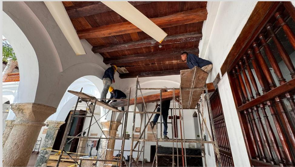
Reemplazo de 19 vigas de madera inmunizada
