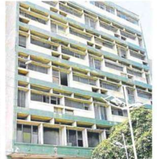
Este edificio de 9 pisos, que está en restauración, será una nueva sede de la Institución Universitaria Bellas Artes y Ciencias de Bolívar. //ZENIA VALDELAMAR - EL UNIVERSAL
